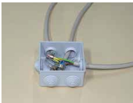
Cablare i cavi nella scatola di derivazione
